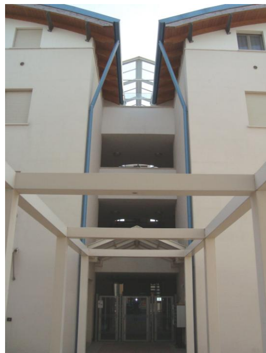
Figura 2 Edificio residenziale - direzionale a Montichiari
