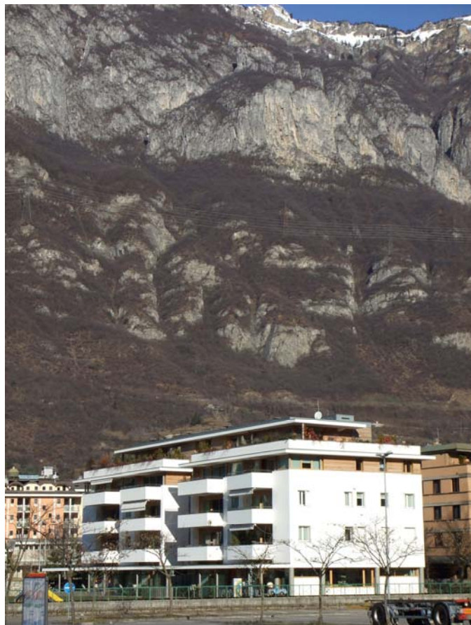
Edificio residenziale e commerciale a Darfo Boario Terme 2003/2006 (con arch. Sergio Ghirardelli)
